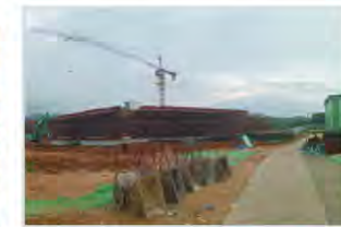
中大教工食堂工程进展
