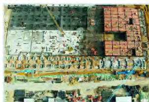
中大海洋科学学院楼工程概况
